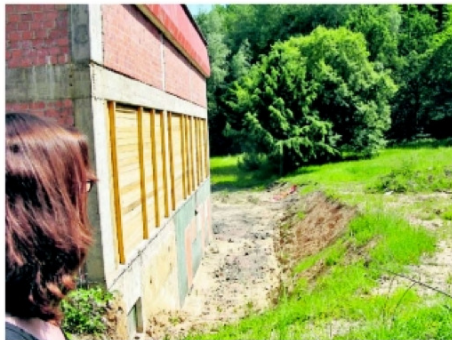
An dem Hallenbad wird hinten angebaut. Dort soll ein Lehrschwimmbecken gebaut werden.
